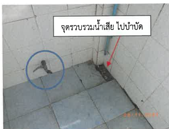
รูปที่ 2-35 ภายในห้องพักขยะทั่วไป มีก๊อกน้ำ และจุด รวบรวมน้ำจากการล้างพื้นห้องพัก
