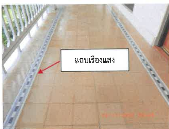
รูปที่ 2-26 แถบเรืองแสง นำทางหนีไฟ บริเวณพื้น ทางเดินภายในอาคาร
