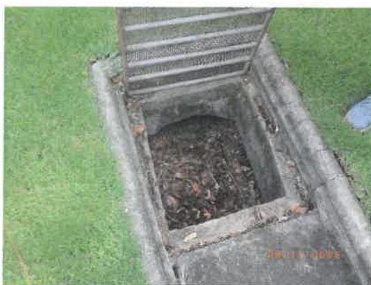
รูปที่ 2-11 บ่อดักตะกอนของรางระบายน้ำฝนที่ตกในพื้นที่ โรงแรม ก่อนระบายออกจากพื้นที่
