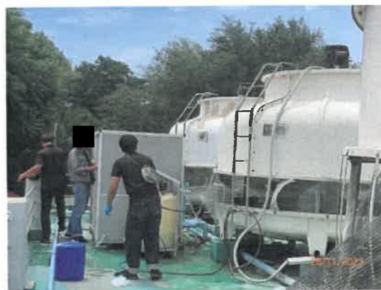
รูปที่ 2-33 (ต่อ) การตรวจสอบ บำรุงรักษา ระบบหอผึ่งน้ำ (Cooling Tower)
