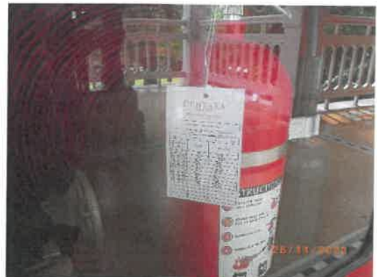
รูปที่ 2-29 ตัวอย่างการตรวจสอบสภาพถังดับเพลิง ประจำเดือน
